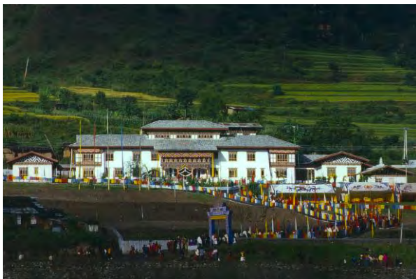
Krankenhauskomplex Punakha, Gesamtansicht
