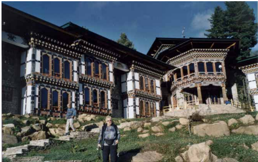
Hotelneubauten wie hier in Bumthang bieten heutzutage sehr viel mehr Komfort als die einfachen Unterkünfte in der Vergangenheit. Die Hotelbesitzer klagen allerdings bereits über Überkapazitäten und mangelnde Auslastung, vor allem während der Zeit außerhalb der Festivalsaison. Photo:Brüggemann
