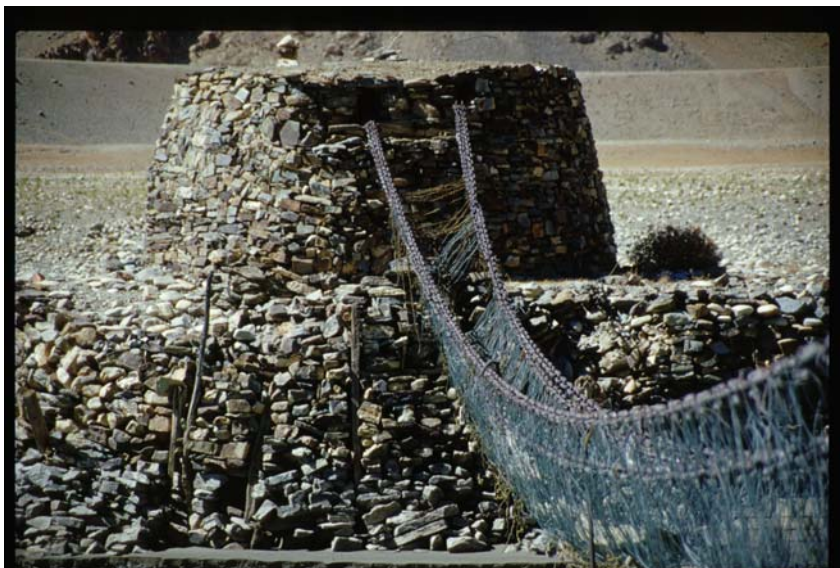
Brückenteil der mehrteiligen Kettenbrücke bei Chung Riwoche über den Yalung Tsangpo in Tibet
