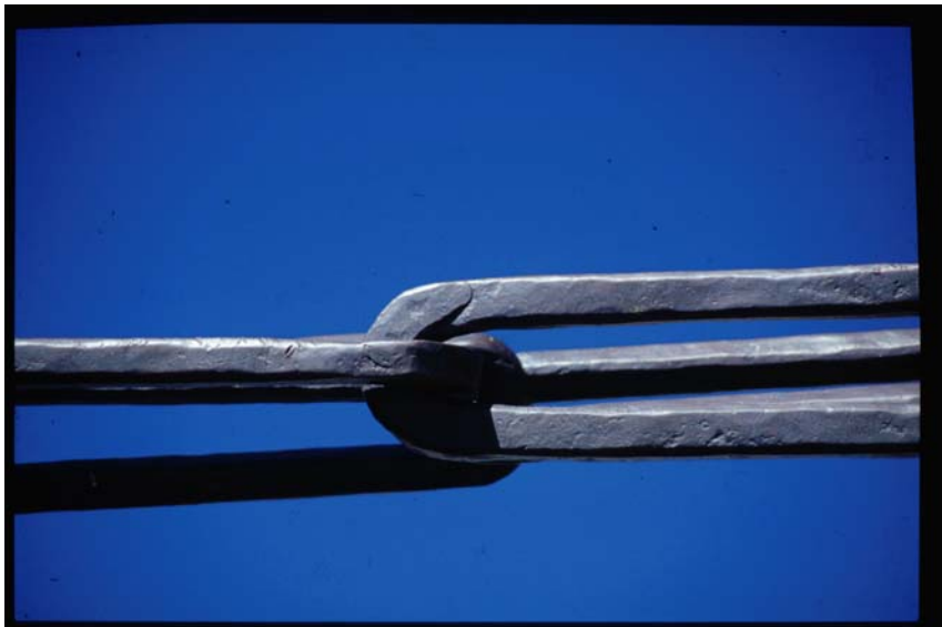
Noch nach 550 Jahren Gebrauch zeigen Tantung Gyalpos Kettenglieder noch keinerlei Rost- oder Korrosionsspuren. Alle Photos: Manfred Gerner
