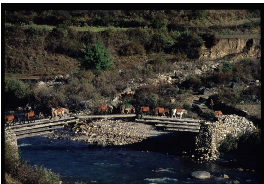
Noch bis 1980 stand und funktionierte diese Holzkrugbrücke auf dem Weg nach Taktsang
