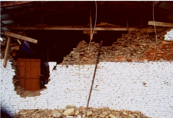
Links: Die eingestürzte Rückwand des Lhakhangs.
