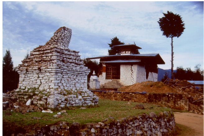
Yangner in Ostbhutan. Von 200 Häusern hat das Erdbeben 50 zerstört. Das Foto zeigt die Umgebung des Yangner Lhakhangs. Foto: M. Gerner
