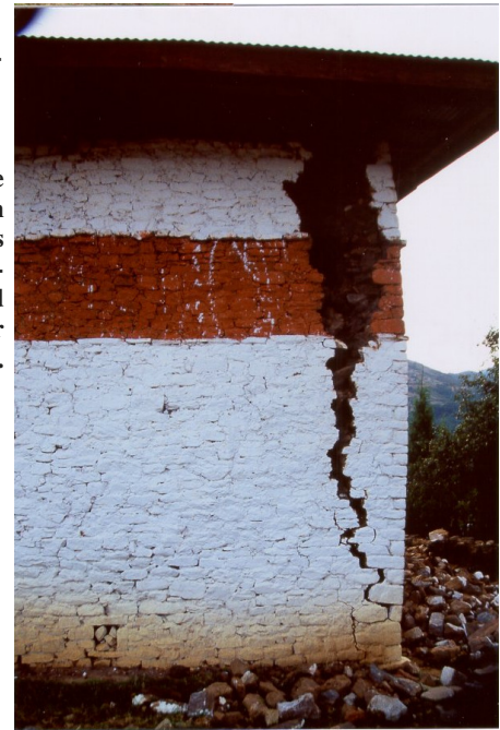
Links: Die eingestürzte Rückwand des Lhakhangs.
