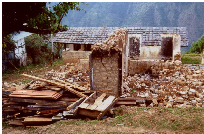
Die Eigentümer dieses völlig zerstörten Wohnhauses haben die Trümmer schon sortiert, um alle wiederverwendbaren Materialien zu bergen.
