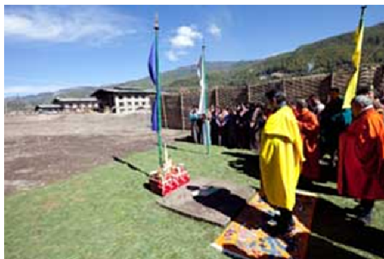
SM der König führt den ersten Spatenstich aus, um Chamkar wieder aufzubauen.
