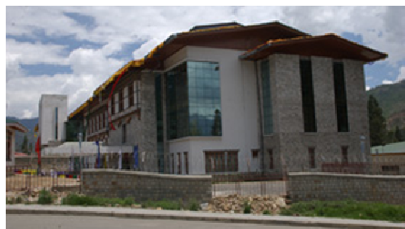
Das neue BBS-TV-Gebäude.
