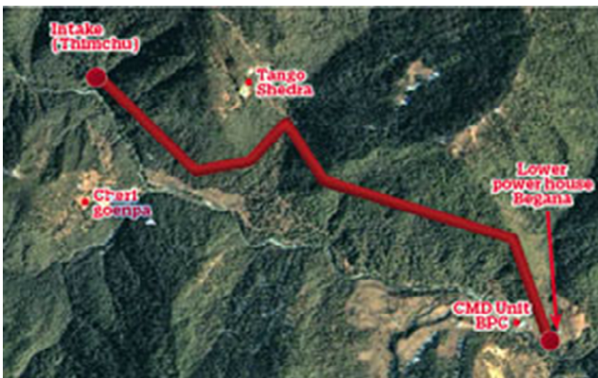
Die neue durch die Berge geführte Anlage zur Strom- und Trinkwassergewinnung führt vom Beginn (links, Thimchu) vorbei an den Klöstern Tango und Cheri schließlich zur Kraftwerkstation in Begana (rechts). Foto: Kuensel
